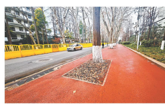
建设一路东侧面人行道部分路段已铺上红色沥青,平整美观。长江日报记者何晓刚 摄
